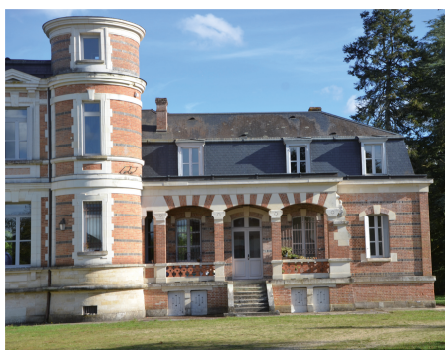
Aile Louis Duthoit au Château d'Ortie à Salbris
